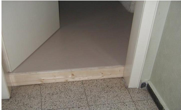
Das GABA-Türabschlussprofil wird in einer Länge von ca. einem Meter geliefert, so dass es immer erst auf die genaue Türbreite zugeschnitten werden muss, um zwischen die Zarge der Tür zu passen (siehe Bild links).
